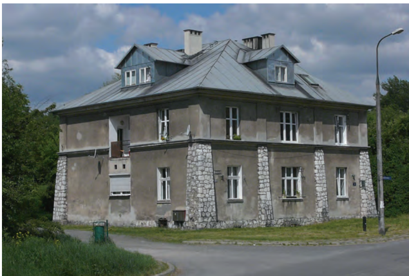
■ Fot. 62. Kraków, ul. Abrahama 3. Dawny budynek administracyjny cmentarza („szary dom”), stan przed remontem
