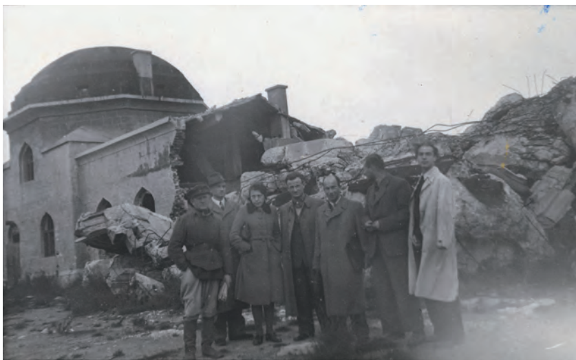
■ Fot. 121. Płaszów, 4 X 1945. Pierwsza wizja lokalna członków OKBZN i WŻKH w Krakowie, na tle ruin domu przedpogrzebowego. Drugi od lewej: sędzia Stanisław Żmuda, piąty: inż. Jakub Stendig
