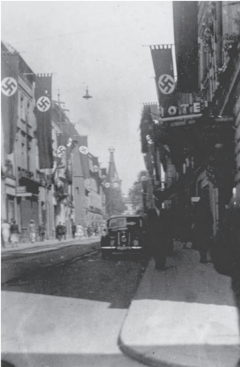
■ Fot. 22. Kraków, ul. Sławkowska
