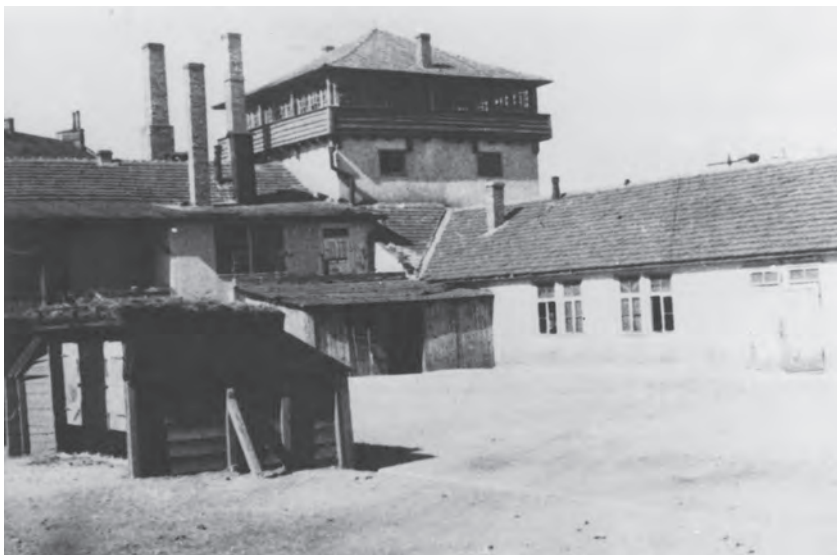
■ Fot. 97. Fragment dziedzińca Wachkaserne , wieża strażnicza w narożniku północnym
