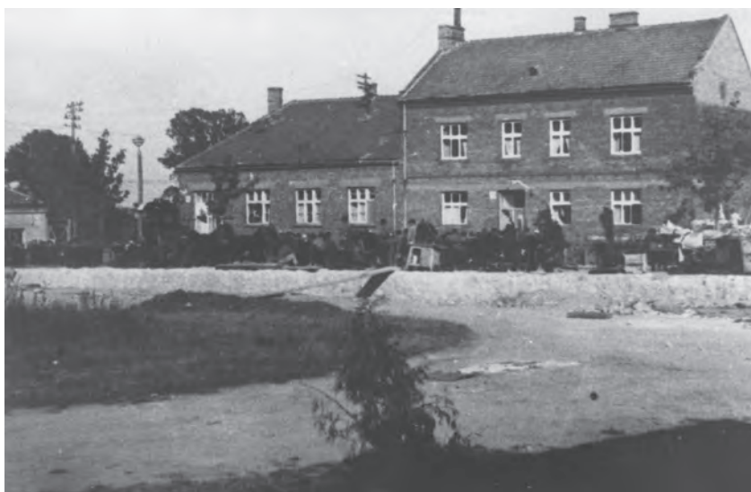
■ Fot. 42. Budynek centrali telefonicznej i kasyna
