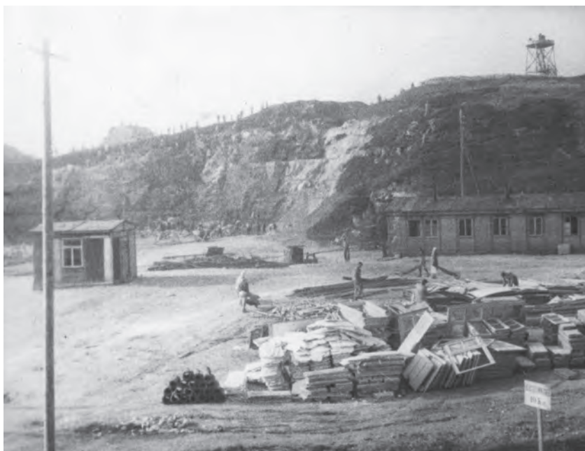
■ Fot. 88. Główny kamieniołom, nad nim wieża przeciwlotnicza
