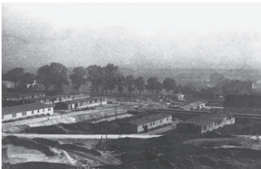
■ Fot. 61. Wschodnie obrzeża obozu, z lewej skrzydło koszar i baraki załogi. Za ulicą staw przeciwpożarowy, warsztaty pracujące dla SS i barak podoficerów, dalej zabudowania grupy Balba
