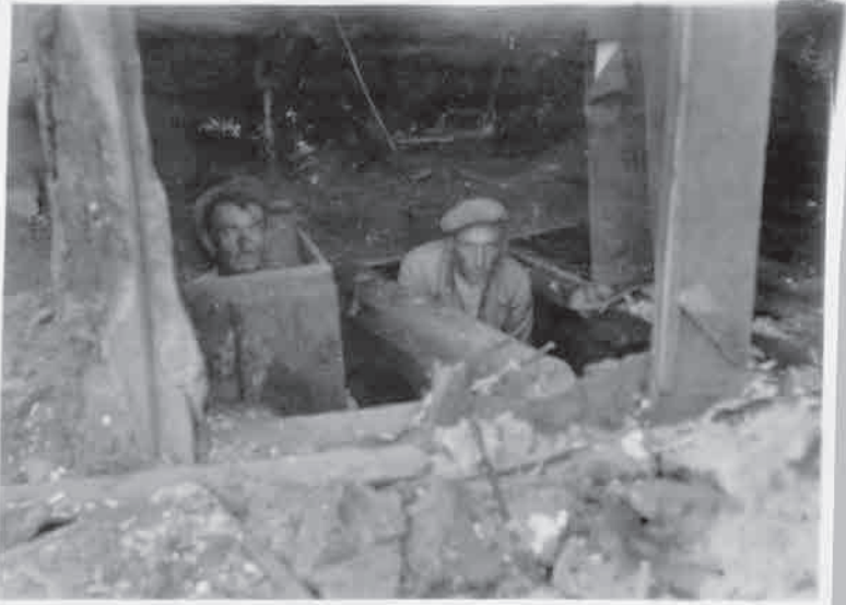
Kryjówka – aby jej wielkość była lepiej widoczna, obok stoi na drabinie Żyd. Zniszczoną podłogę wykorzystano jako miejsce ukrycia skór, bielizny oraz ubrań.
