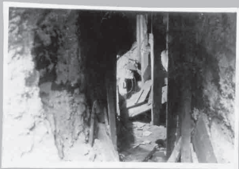
Wnętrze schronu. Schron został częściowo zasypany z powodu wykopywania otworów oraz spalenia szalunku.
