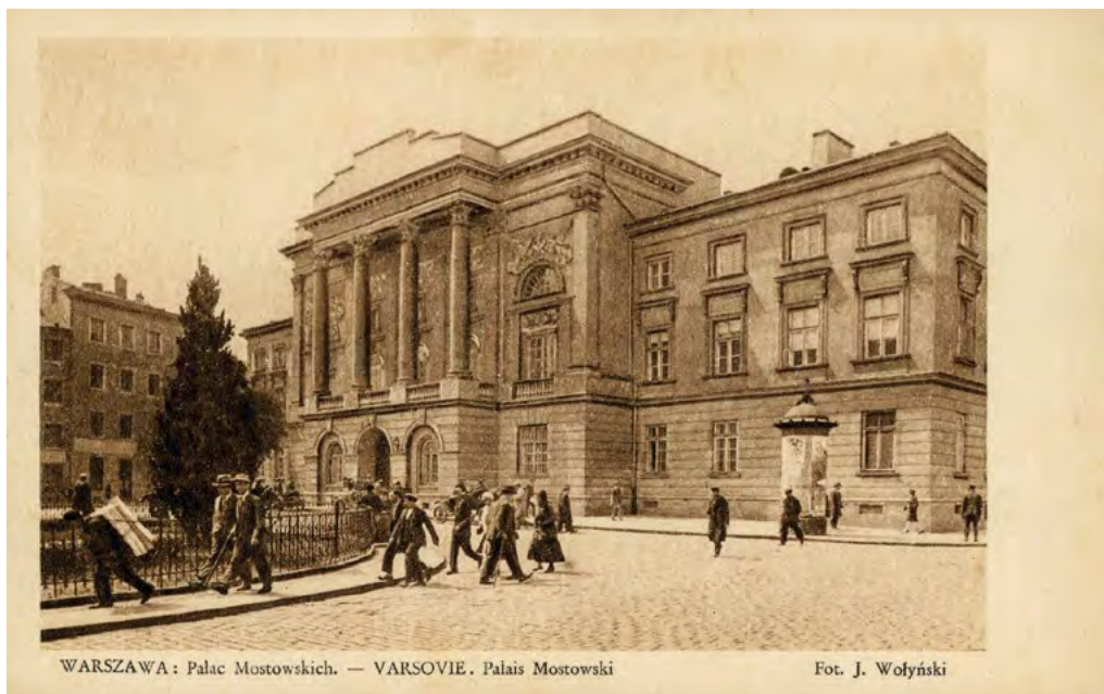
Warszawa, pałac Mostowskich Źródło: Biblioteka Narodowa
