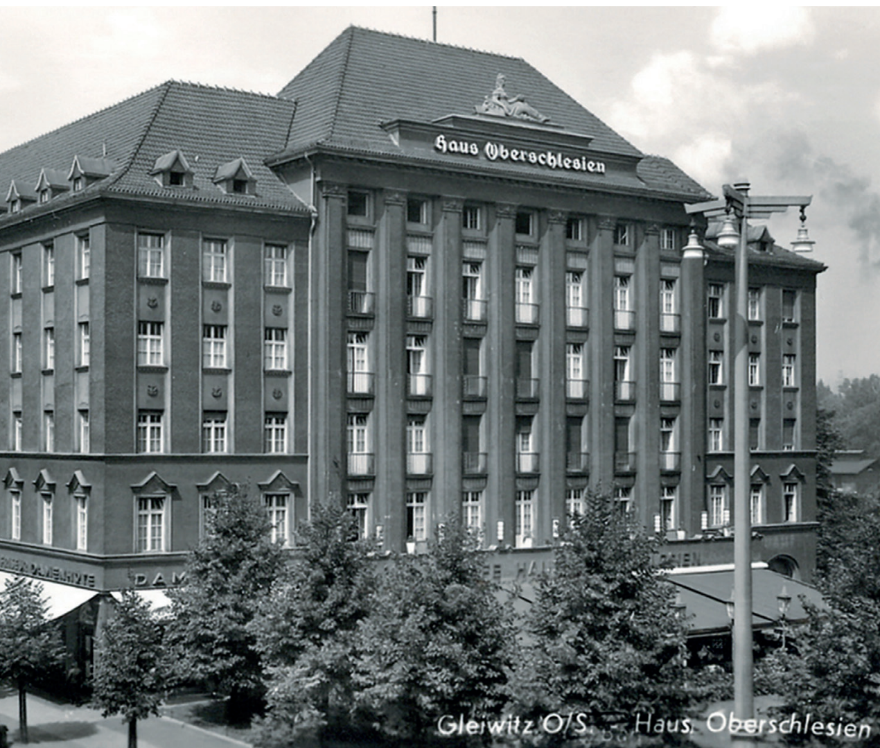
■ HOTEL „HAUS OBERSCHLESIEN” W GLIWICACH NA POCZTÓWCE Z LAT 30. XX W. FOT. MUZEUM W GLIWICACH
