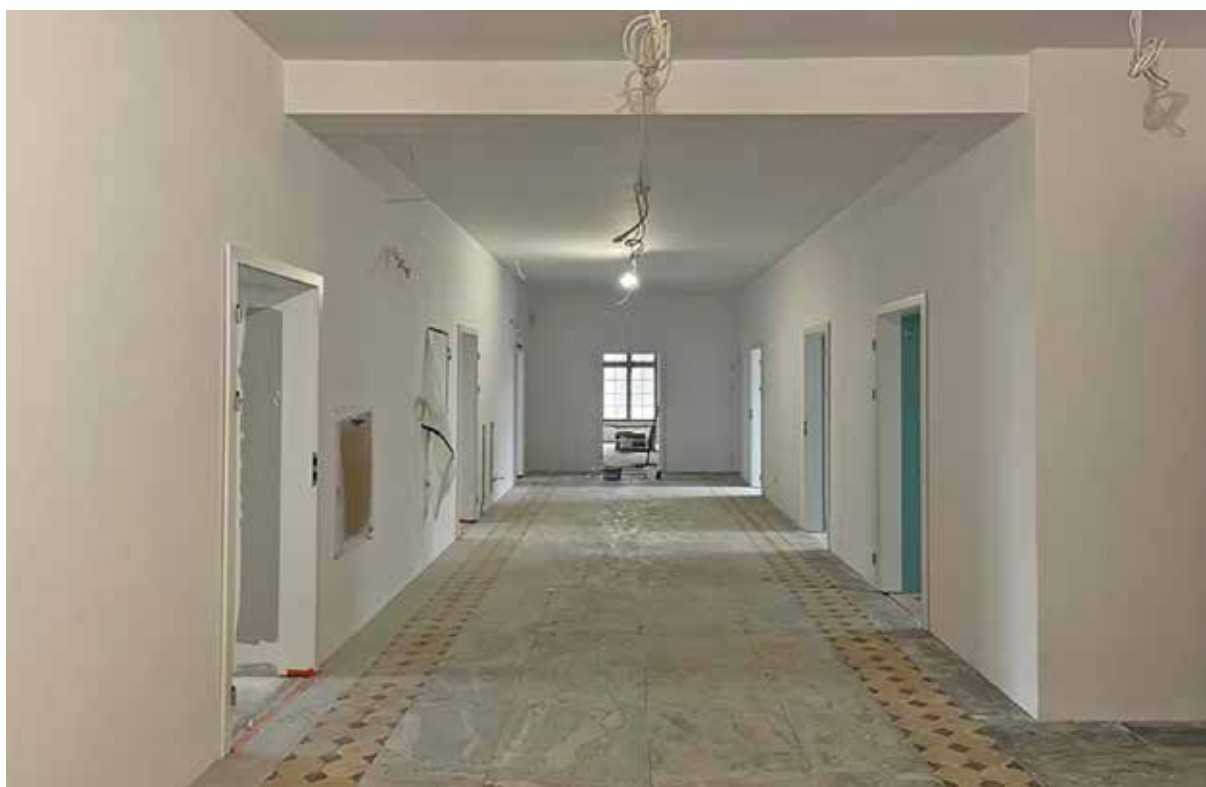
Wnętrze budynku (korytarz II p.) w trakcie realizacji prac. Fot. MŻWiWP PRL
