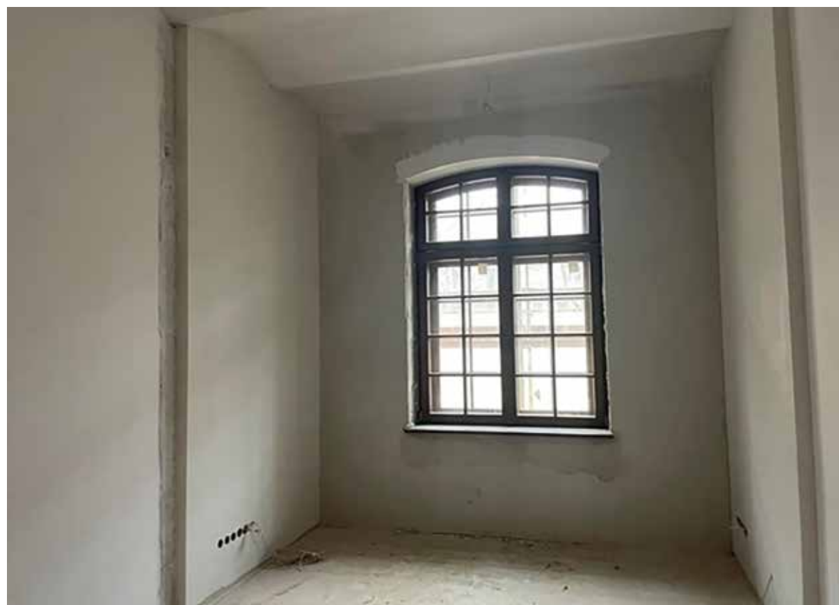
Wnętrze pomieszczenia biurowego w trakcie realizacji prac. Fot. MŻWiWP PRL
