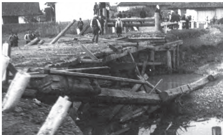
Fot. 3. Lipnica Wielka, przysiółek Murowanica – uszkodzony most na potoku Lipnica, na drodze z Namiestowa do Jabłonki. Za mostem widoczny zamknięty szlaban, zaprojektowany przez mjr. Józefa Olendra (ze zbiorów Piotra Sadowskiego).
