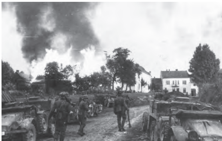
Fot. 39. Strzelcy z 2. Dywizji Pancernej na tle płonącej zabudowy ul. Malejowskiej w Jordanowie. Pośrodku kadru widoczny jest za drzewami biały budynek synagogi (Niemcy podpalili go kilka dni później). Fotografię wykonano z odcinka obecnej ul. Słowackiego (ze zbiorów Piotra Sadowskiego).
