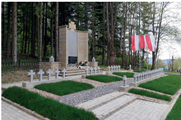
Fot. 52. Cmentarz w Wysokiej po remoncie zakończonym w 2023 r. (fot. Piotr Sadowski).
