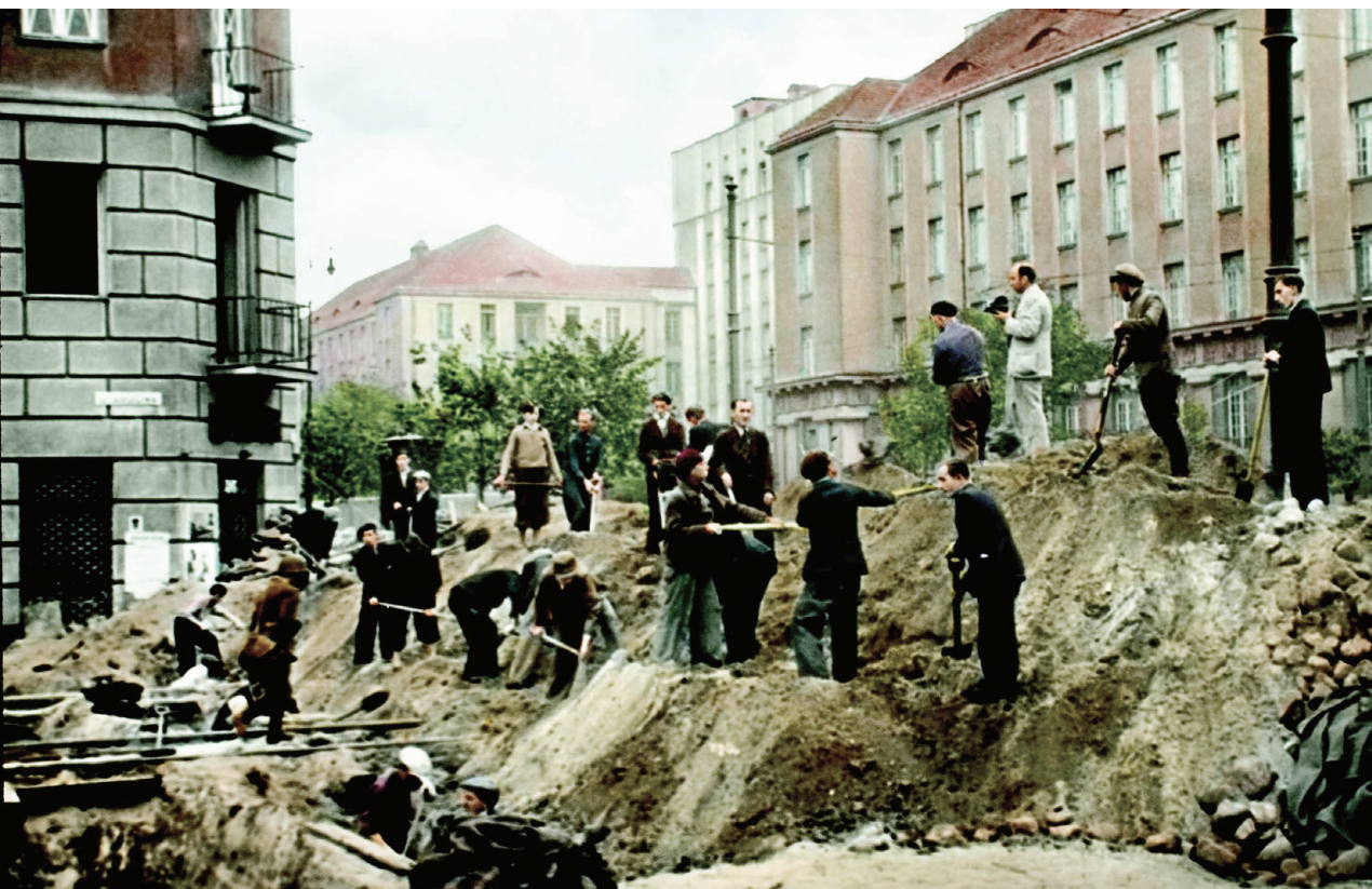
■ BUDOWA UMOCNIEŃ NA WARSZAWSKIEJ PRADZE, WRZESIEŃ 1939 R. FOT. JULIEN BRYAN / AIPN
