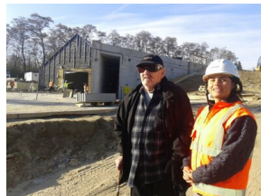
Abraham Segal na budowie Muzeum im. Rodziny Ulmów w Markowej (2015). Fot. Mateusz Szpytma
