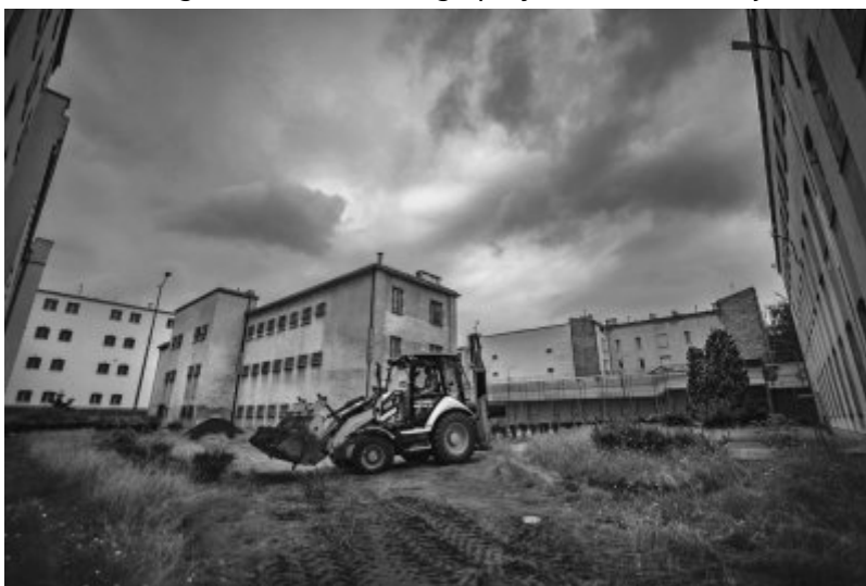
BPiI wznowiło prace na terenie dawnego Aresztu Śledczego przy ul. Rakowieckiej w Warszawie – 11 czerwca 2018
