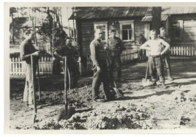
Żołnierze niemieccy podczas budowy umocnień i baraków w miejscowości Schnakendorf koło Gniezdowa wiosną-latem 1942 r.
