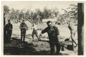
Żołnierze niemieccy podczas budowy umocnień i baraków w miejscowości Schnakendorf koło Gniezdowa wiosną-latem 1942 r.
