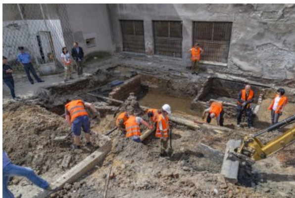
Warszawa. Rakowiecka. Prace na podwórzu, widoczne fragmenty wcześniejszej zabudowy aresztu
