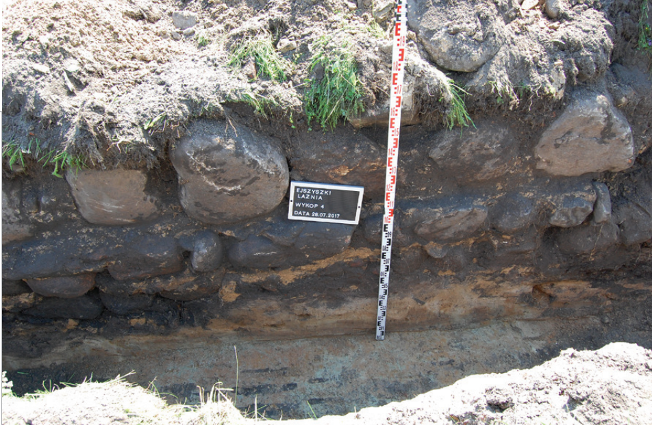
Ejszyszki (Litwa) – fundament budynku żydowskiej łaźni. Fot. Leon Popek
