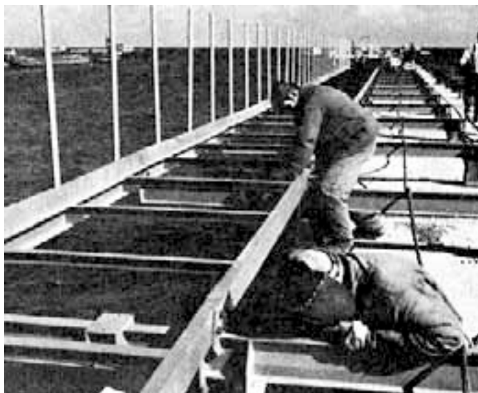
Budowa Portu Północnego
