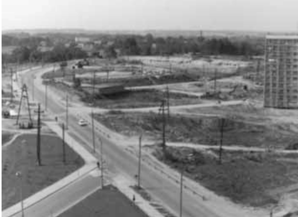
Jastrzębie Zdrój – osiedle w budowie
